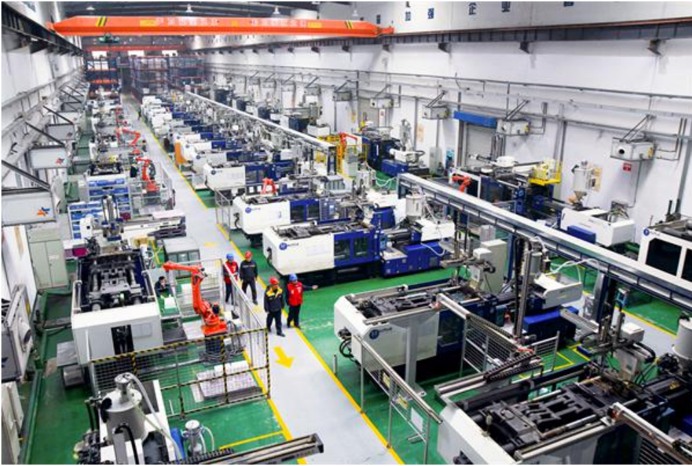
国网盘锦供电公司员工协助企业检查用电设备情况 摄影 李岚松
